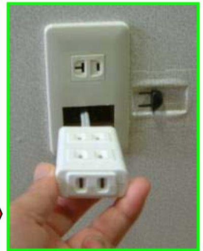
飛び出したコンセント 引っ張ると3口 テーブルタップが出てくる
